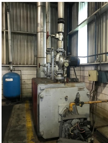
Fotografía 7. Calderín marca Lasian de 20 BHP
